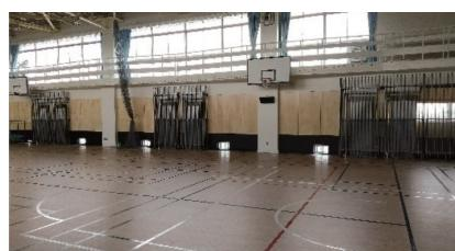
エアコン室内機とSCREENパネルが上下にセットで設置されている
